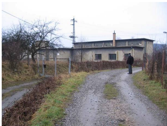
Obr.37 nevyužitý objekt bývalé úpravní vody ve Všenorech – návrh úpravy vody+technologie +čerpací stanice
