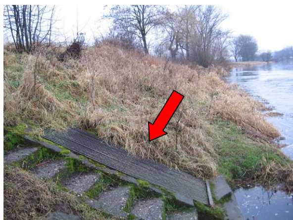
Obr. 38. Odběrný objekt z Berounky
