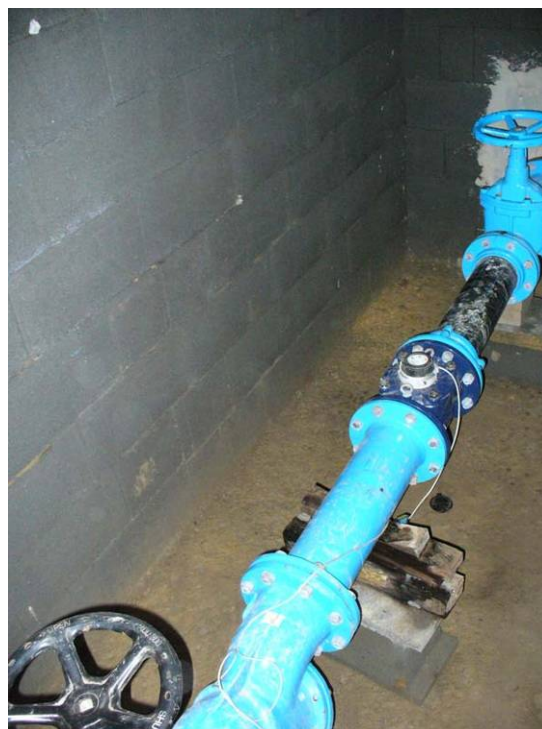
Obr. 14 Foto - předávací místo – VDJ Včelník - šachta
